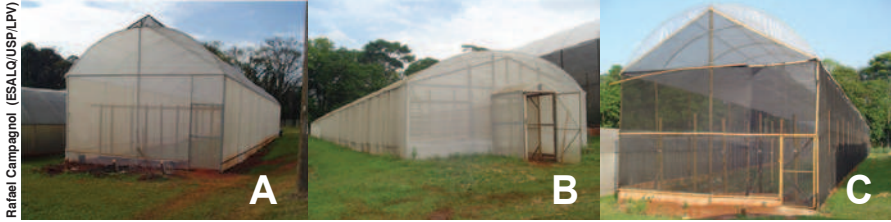
Figura 1. Casas de vegetação com diferentes dimensões e materiais utilizados no cultivo de mini melancia. Estrutura metálica (A); Estrutura composta por madeira e pilares de concreto (B); Estrutura de madeira (C).
