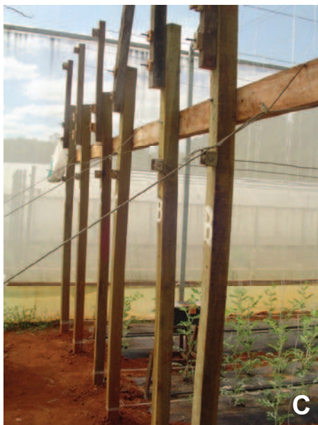
Figura 4. Estrutura para condução das plantas de mini melancia no sentido vertical. Distribuição dos mourões no interior da casa de vegetação (A); Bambus sustentando os arames e fitilhos presos a estes (B); Detalhe do travamento da estrutura de condução (C).
