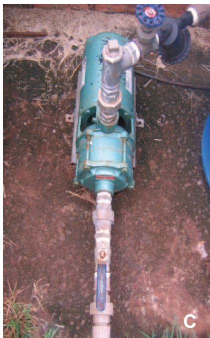
Figura 13. Sistema de irrigação das plantas. Gotejadores utilizados para o manejo da irrigação (A); Reservatório de solução nutritiva (B); Motobomba e filtro de disco (C).
