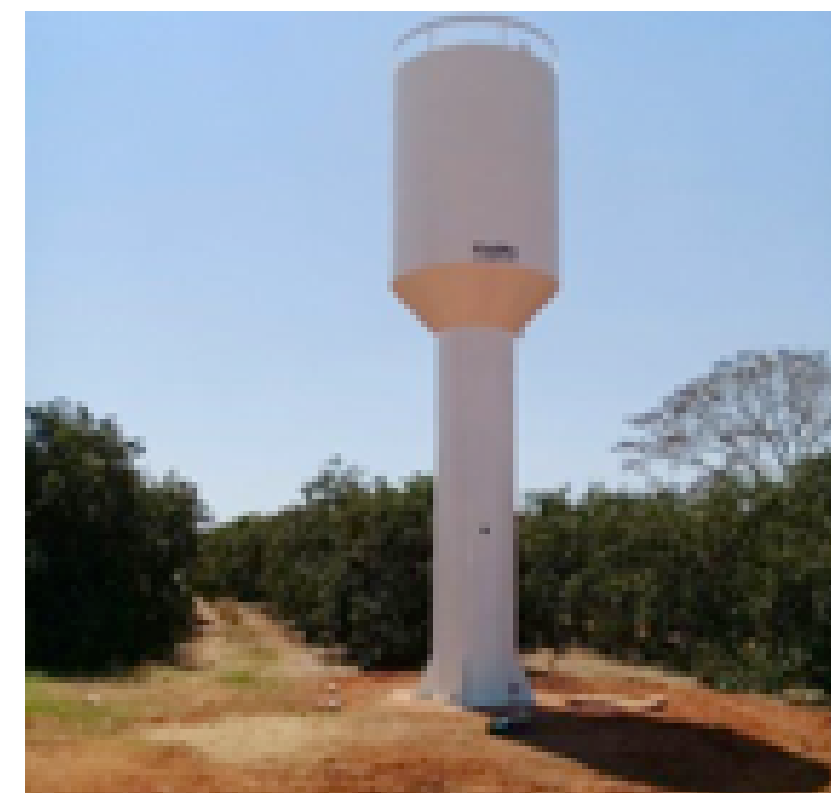
Figura 8: Reservatório do tipo 'taça'. Fonte: Fia Agro
