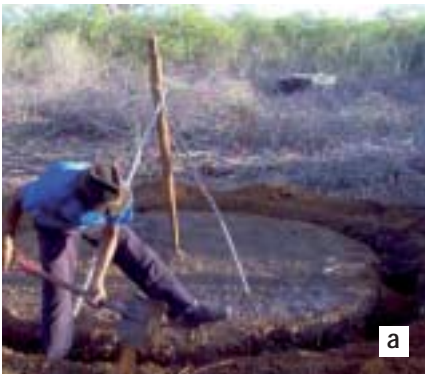
Figura 20 – Escavação (a) e assentamento da base do forno (b)
