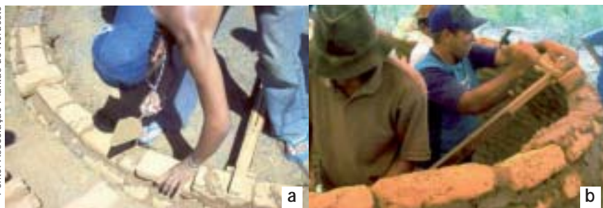
Figura 21 – Marcação dos suspiros (a) e construção da parede (b)
