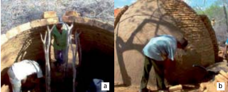
Figura 22 – Construção da porta (a) e reboco do forno (b)
