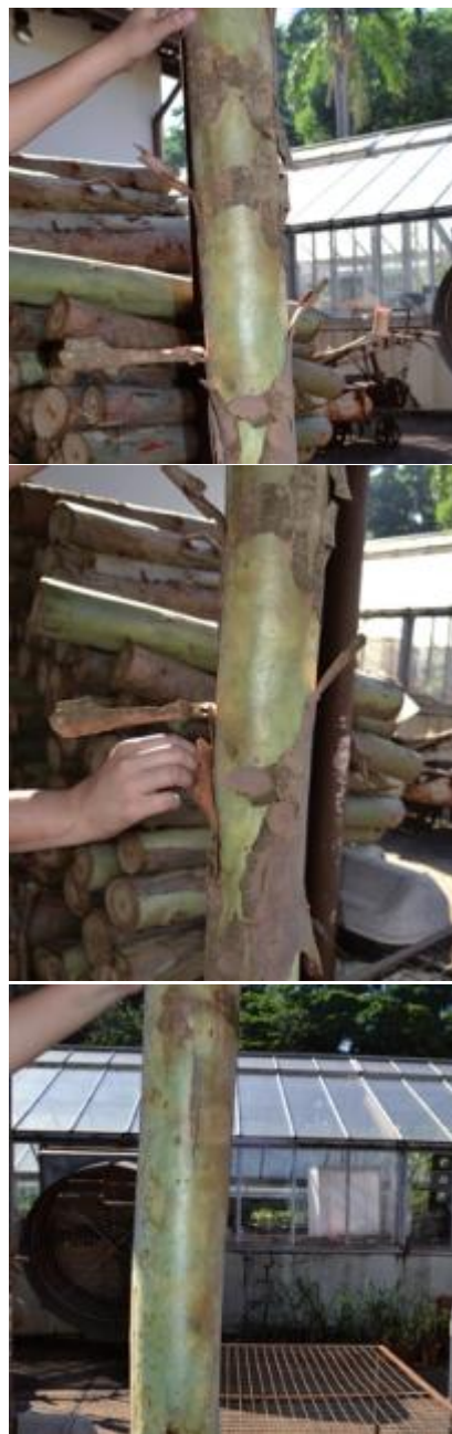
Figura 6. Limpeza das toras de eucalipto
