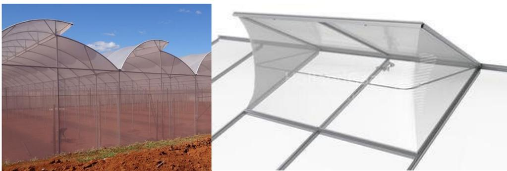
Figura 2 - Aberturas para ventilação.
